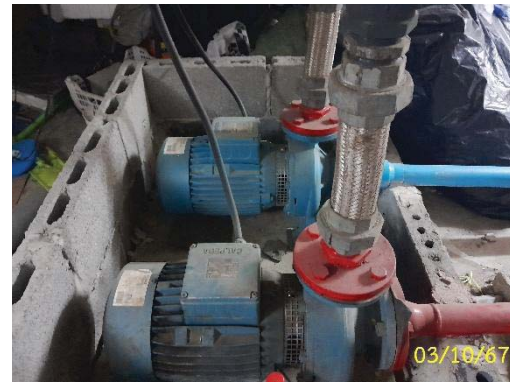
ปั๊มและถังเก็บน้ำใช้ใต้ดิน
