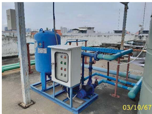
ปั๊มและถังเก็บน้ำใช้ชั้นดาดฟ้า
