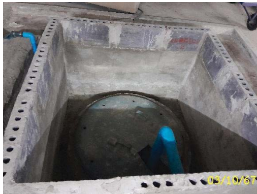
ปั๊มและถังเก็บน้ำใช้ใต้ดิน
